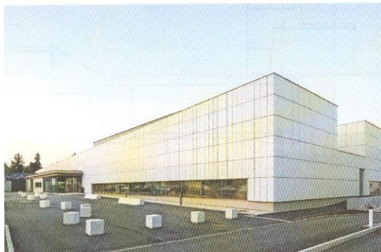
Die Gebäudehülle aus weißglasierten großformatigen Keramikelementen unterstreicht den linearen Charakter des großen kubischen Baukörpers.
